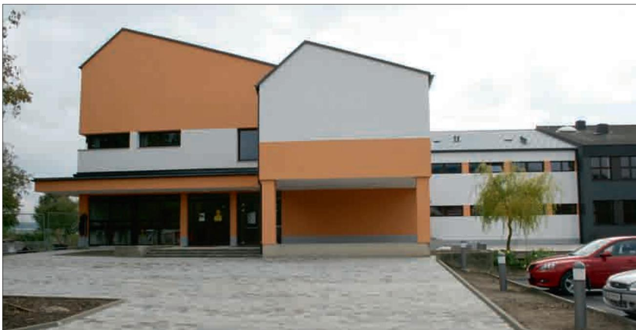
Der Anfang Juli in Angriff genommene 1. Sanierungsabschnitt in der Hauptschule Persenbeug steht vor dem Abschluss. Neben einer Fassadensanierung samt teilweisen Fenstertausch, der Erneuerung des Daches sowie wärmetechnischer Maßnahmen wurden auch die Außenanlagen teilweise neu gestaltet. Diese Arbeiten konnten dank der vorherrschenden Witterung noch ausgeführt werden. Ein Dankeschön in diesem Zusammenhang an unsere heimischen Firmen, die wesentlich zum Gelingen des Vor-
